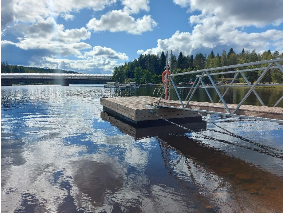
Kuva 1. Nykyinen uimalaituri. Uusi melontalaituri asennetaan nykyisen laiturin vasemmalle puolelle.
