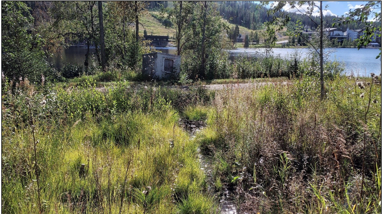
Kuva 3. Lähteikkö 1 kuvattu tihkupintojen pohjoispuolelta etelän suuntaan. Tihkupinnat ovat heinien ja sarojen peitossa. Lähdepuro on selkeämmin havaittavissa.
