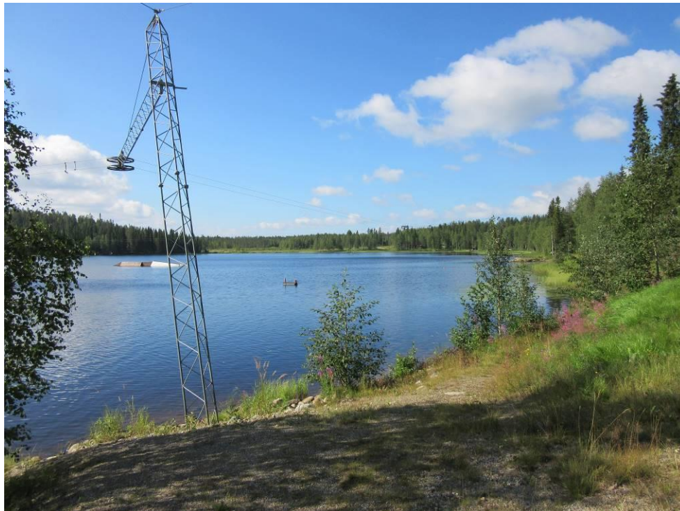
Kuva 21 Wakeboard -radan rakenteita kesäaikaan (Kuva: Ulla-Maija Oikarinen, 7.8.2019)
