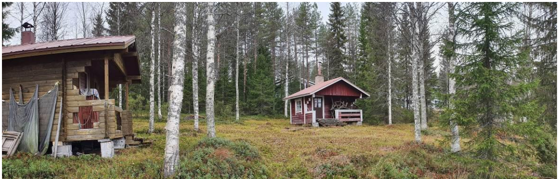
Kuva 9 Korttelin 1 piestä rakennuskantaa
