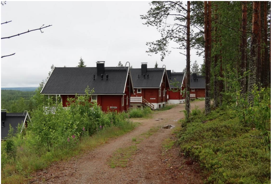
Kuva 8 Muutosalueen vieressä olevan korttelin 11 rakennuksia. Kulkuyhteys tulee kuvassa näkyvälle tielle
