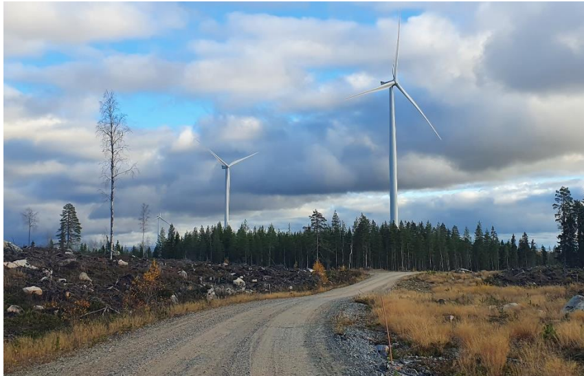
Kuva 42. Tiestöä Kivivaara-Peuravaaran tuulivoimapuiston alueella.
