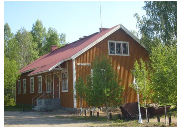
Kuva 10. Hyrynsalmen sotahistoriallinen kohde ja valtakunnallisesti arvokas rakennettu kulttuuriympäristö "Vanha asema" säästyi saksalaisten tuhoamiselta (kuva: Tiina Kinnunen 2015).
